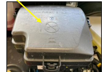
Zekering en relaiskast, hierin bevinden zich de verschillende zekeringen en relais voor het elektrische systeem van de Iveco.
